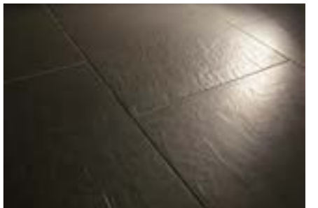
Tassos grafito 30x60 trabado a 10 cm / Broken joint 10 cm.
